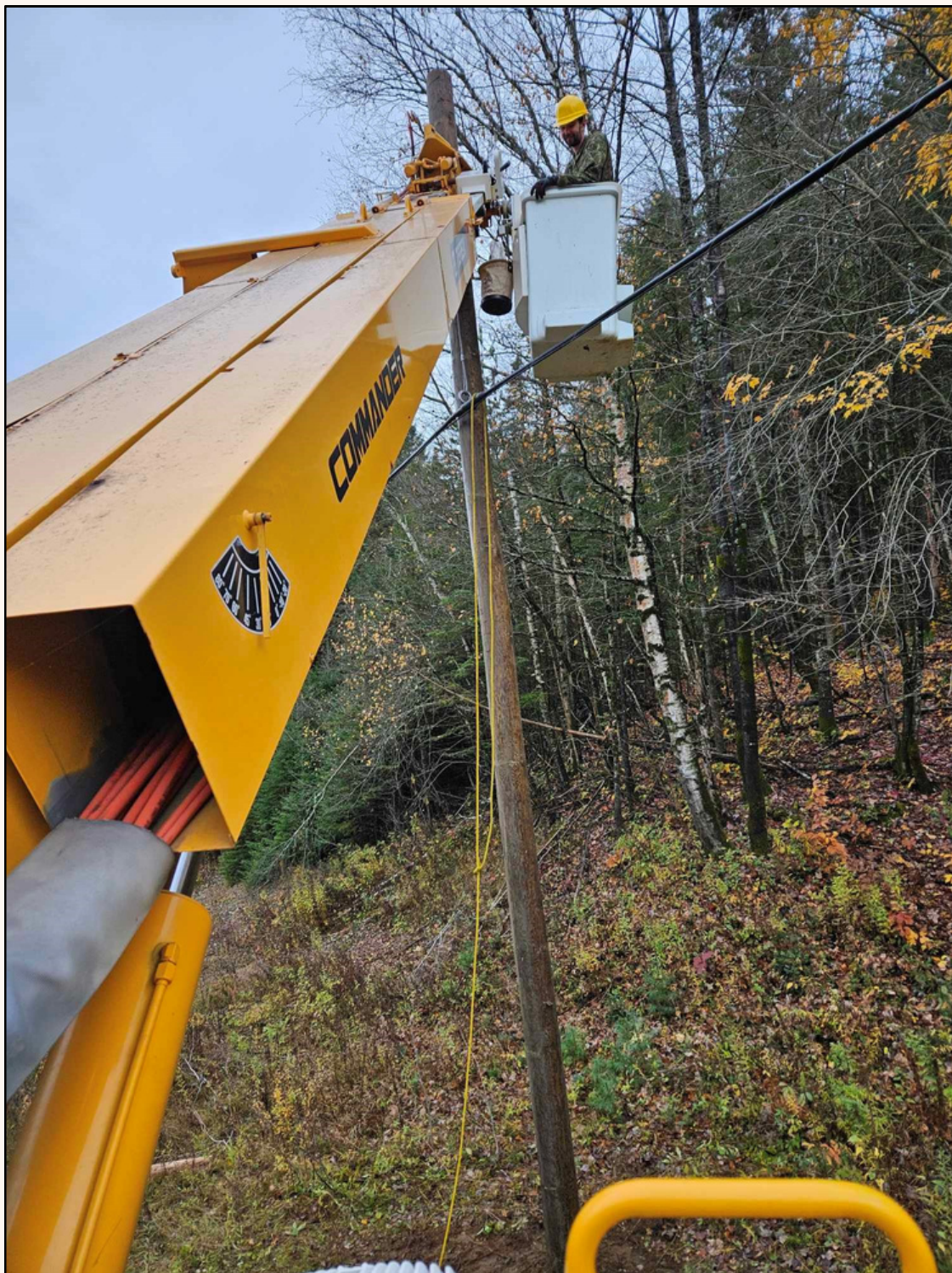
Cpl Dussault en pleine installation d'un poteau dans les secteurs d'entraînement à Valcartier.
